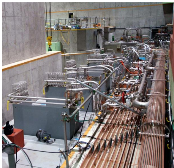
図 3、サービススペース内配線、配管（左）と磁石との結合に用いる冷却水、電流の即着脱コネクタ付ブリッジ装置（上）。
